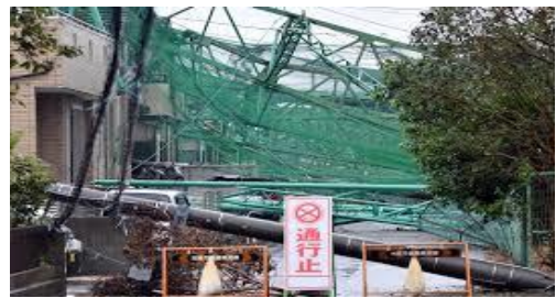
台風15号の暴風によるゴルフ練習場の鉄柱倒壊（写真）
