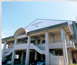
柔道場・トレーニングルーム・体育館
