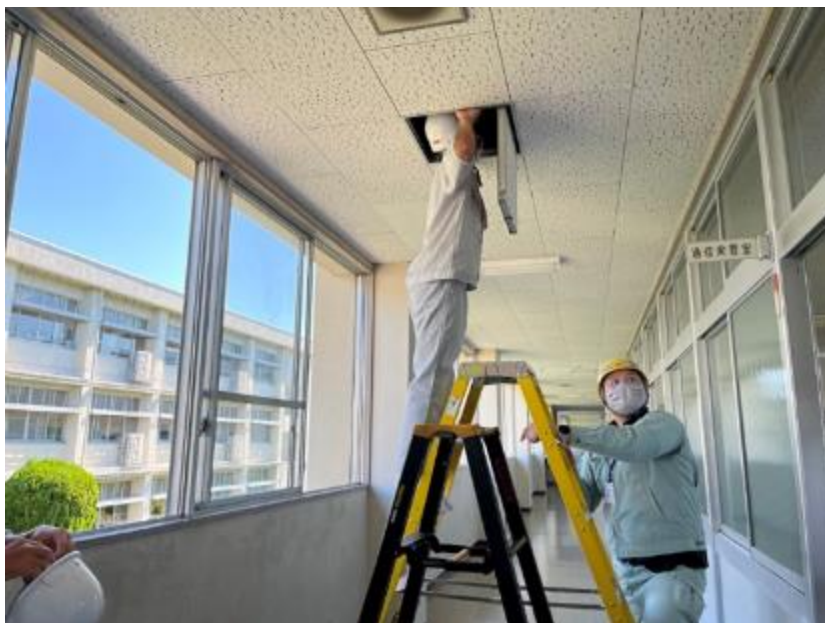
【課題研究 LANケーブル配線作業】
