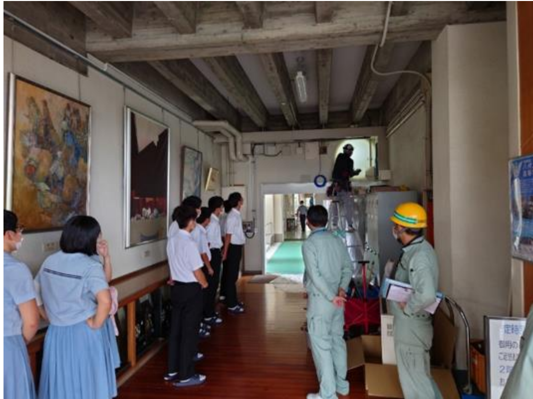
【施工現場見学（通信用BOXの取付）】
