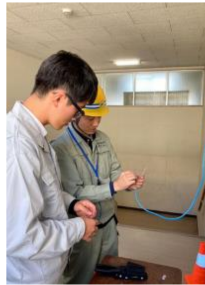
【生徒によるLANケーブル配線 作業状況】
