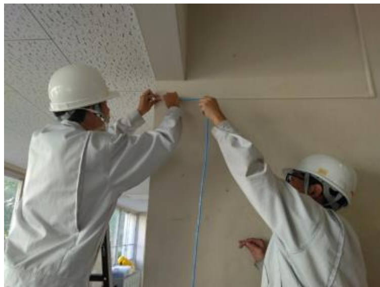
【生徒によるLANケーブル配線 作業状況】
