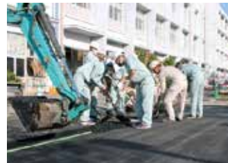
専門実習①(舗装)
