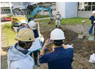
専門実習③(管工事)
