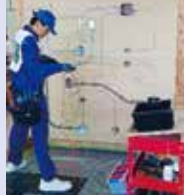
ものづくりコンテスト 電気工事部門
