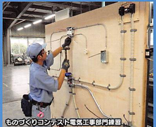
電気工事実習
