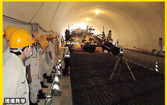
締固めローラー運転講習
