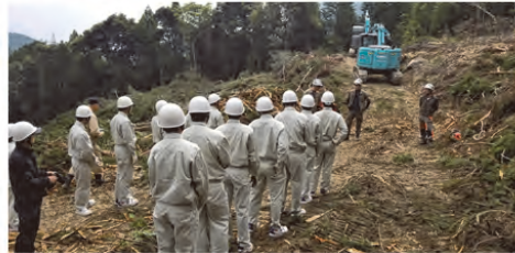
伐採現場の様子
