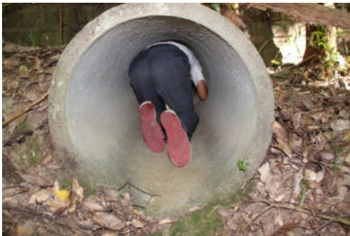
写真 3. 排水管内の痕跡調査.
