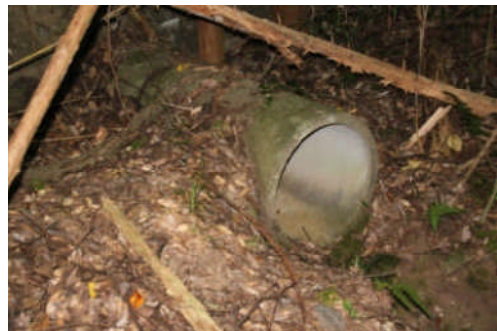
写真2. 調査場所の排水管(上側, 下側).
