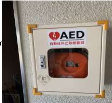
職員玄関（事務室前）
