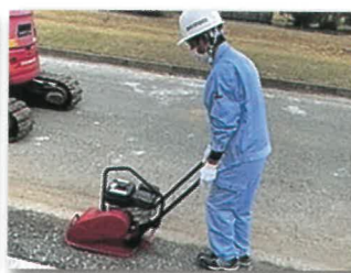
農業土木施工(実習)
