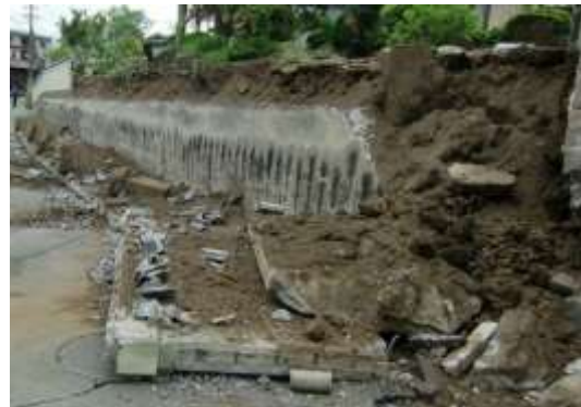
倒壊した塀で通れなくなった道路(右)
