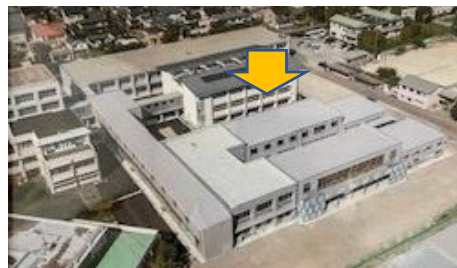
実習棟3号館（手前）
