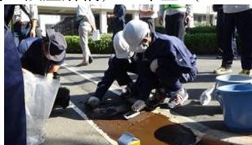
段差のすり付け補修
