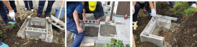
2段目、場所によっては3段目とブロックを配置 メッシュで補強しネットを打設
