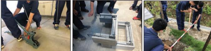
水準測量を行い杭を打ちます 加工したブロックを水平に設置 鉄筋を配置しモルタルで固定
