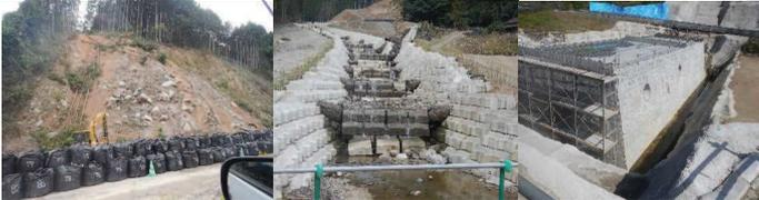
写真-3 斜面崩壊の跡 写真-4 応急的砂防堰堤建設 写真-5 本格復旧砂防堰堤建設
