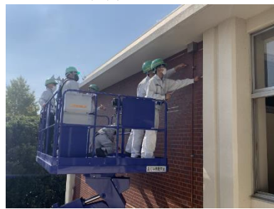
非破壊試験（打診検査）
