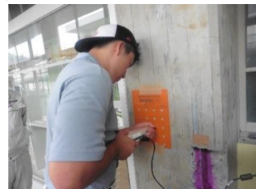
非破壊試験（中性化検査）
