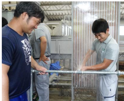
管工事補修実習
