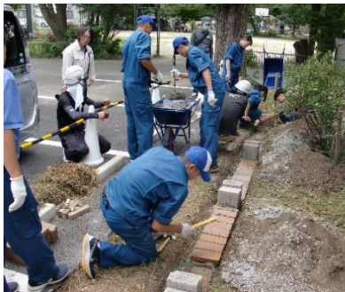
近隣福祉施設への花壇施工
