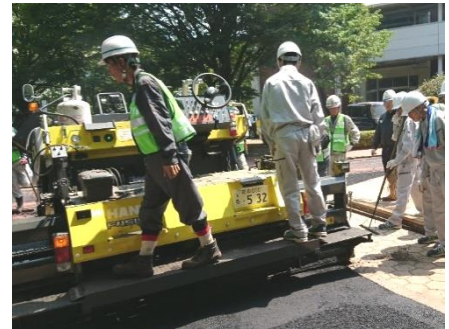
アスファルト舗装実習
