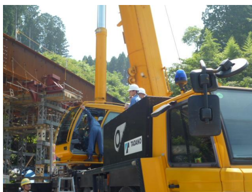
④160tオールテレーンクレーン操作
