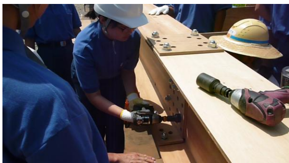
①木製桁架設体験
