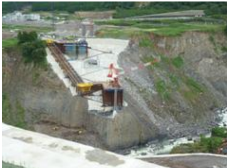
阿蘇大橋建設現場
