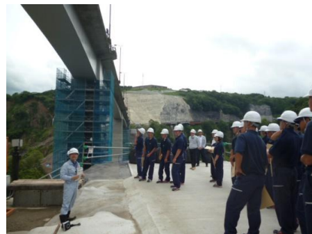
長陽大橋炭素繊維巻立て工法
