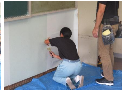
生徒による施工
