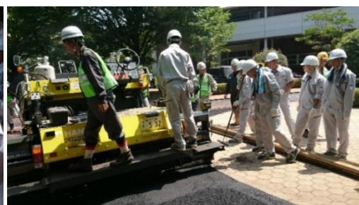
アスファルトフィニッシャによる敷均し
