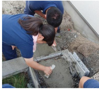
コンクリートを均す
