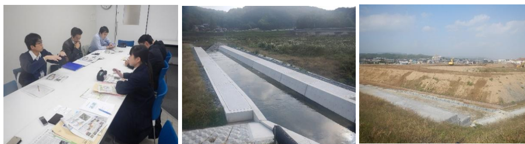
被害と復旧工事の説明
