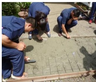
コンクリートを均す
