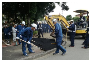
土木科の舗装実習
