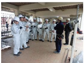
配筋検査実習
