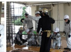
壁・梁鉄筋結束
