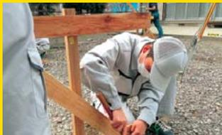
丁張とは、建造物をつくる際に基礎の高さの目印として使用します。木杭を打ち水平の板を取り付けて設置します。
