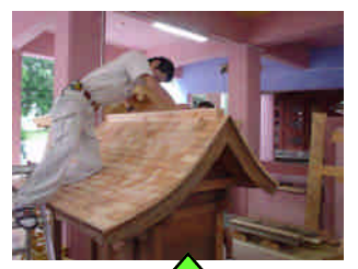
板葺屋根の取付
