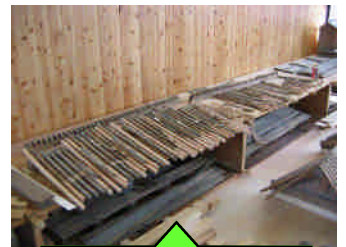
垂木の補修後
