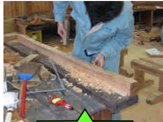
桁の補修
