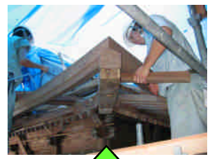
配付垂木の取付
