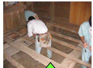
床板の取外し
