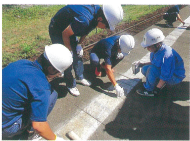
多良木駅点字ブロック修復工事
