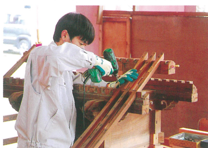
祠（ほくら）の修復
