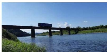
2014年（平成26年）7月18日に文化庁のホームページにアップされた報道発表「登録有形文化財（建造物）の登録について」には、第四橋梁について、「球磨川にかかる第四橋梁は、橋長322m、単線仕様の鋼製上路式プレートガーダー14連桁橋と長大なもので、くま川鉄道を代表する土木構造物である」と記してあります。
