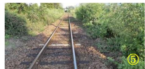
かと言って、くま川鉄道のように慢性的な赤字を抱える第三セクターに4万本近い枕木を全てコンクリート化することはコスト的に難しいと思われます。運輸安全委員会は、その場合、数本に1本の割合で交換するだけでも事故防止に有効だと付言しています。これを受けてでしょうか？遠心力で線路を外側に押し広げる力がかかるカーブ付近を中心に、写真⑤（肥後西村駅と一武駅の間）のように4本に1本の割合でコンクリートの枕木を敷設した箇所が何箇所も見られます。
