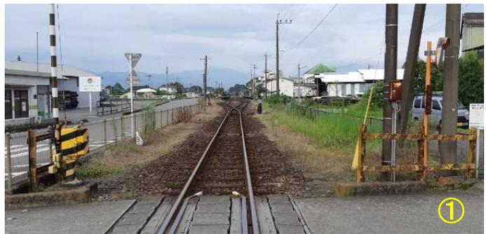
ここで行き違いの人吉温泉行きの列車が向かって右側の1番線から進行してきたときは、一見ポイントが開いていないように思われますが、車輪のフランジでトングレール（可動部分の先端が尖っているレール）を押しつけて通過することができます。この場合、列車等が通過した後にばねの力でトングレールは元の状態に戻ります。高速で走行するところや走行頻度の高いところには不向きですが、ポイント操作が不要なのでローカル線の行違駅や、路面電車などで使用されています。スプリングポイントの転轍器標識は、スプリングを意味するSの字が入っています。
