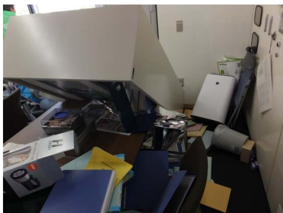
本震で倒れた重戸棚等（事務室）
