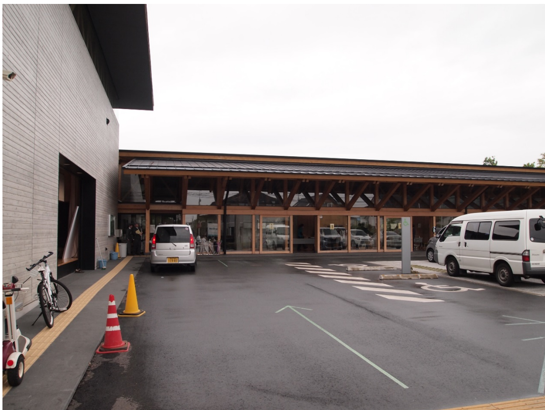
4月25日 体育館・プール棟, 管理棟
