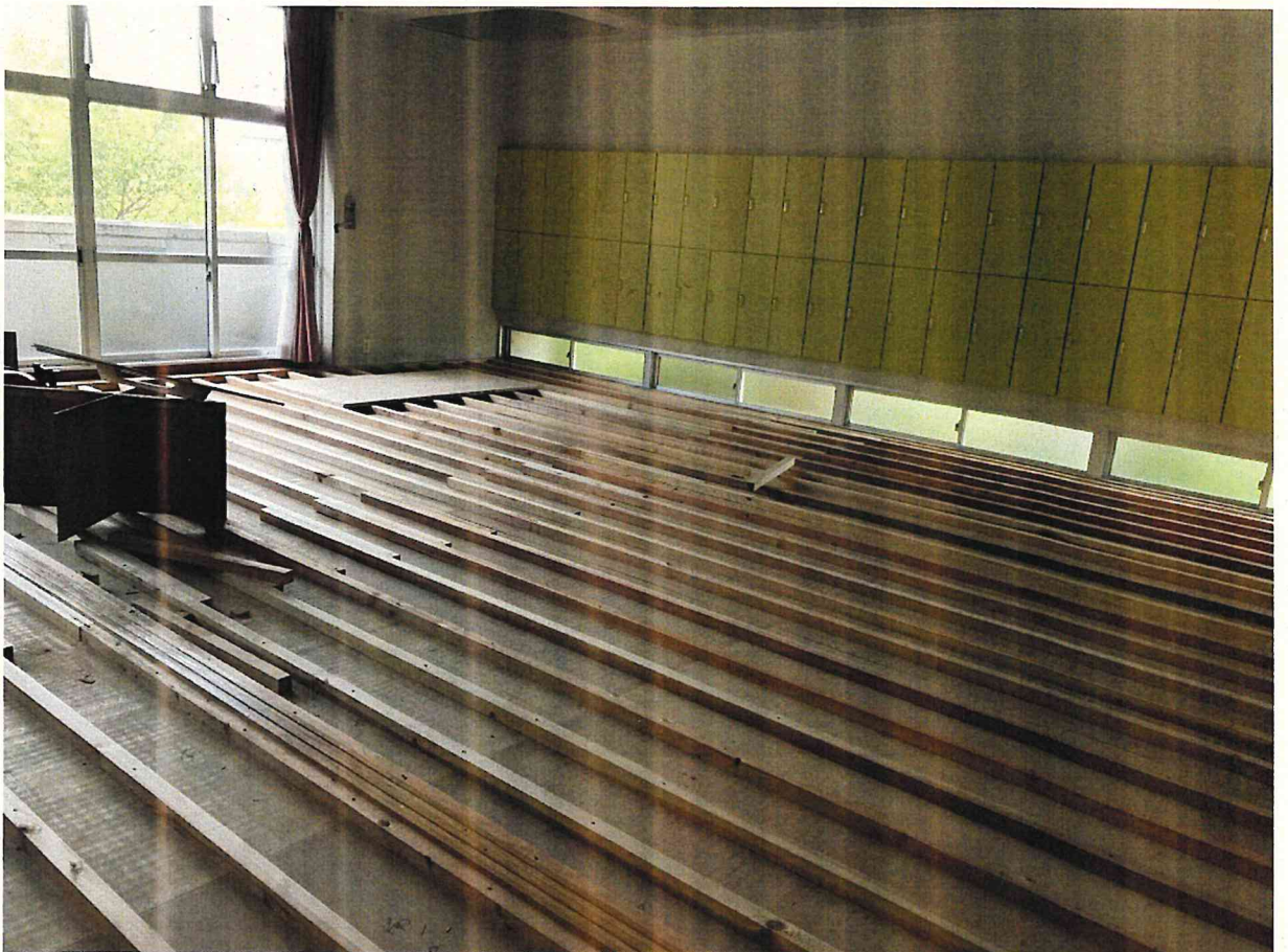
芦北高校セミナーハウス借用（仮設工事）
