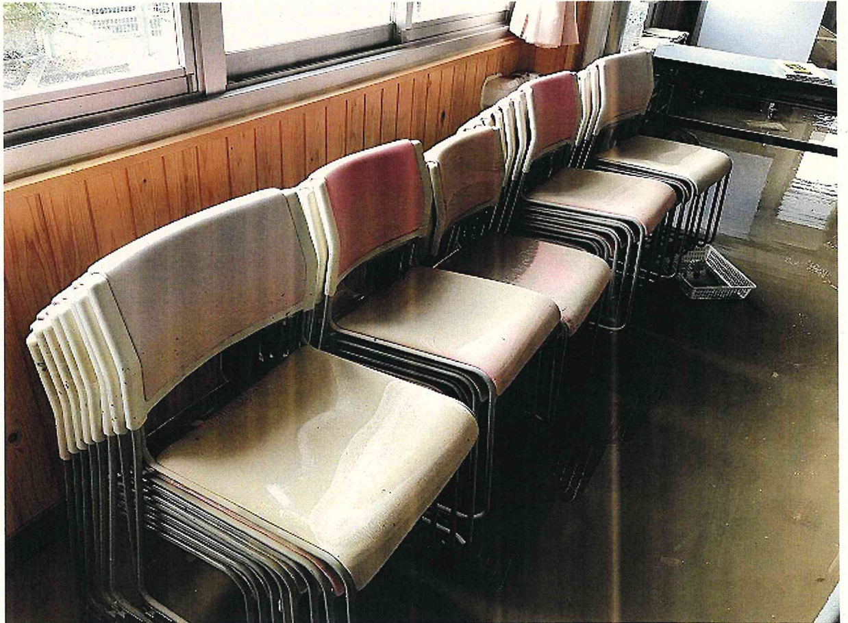
窓サッシ上付近まで冠水
